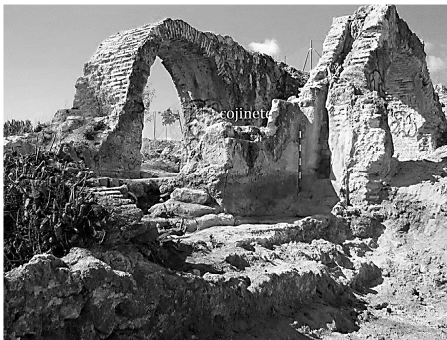
Figura 4: Panorámica de los dos acueductos construidos en fábrica de ladrillo que trasladaban el caudal necesario para poner en movimiento las tres aceñas de las instalaciones molinarias. A la izquierda el acueducto de los Molinos de papel del Cejo (ca. 1731).
