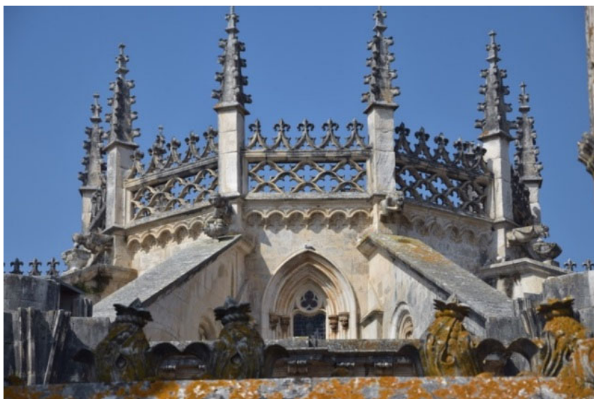
Fig. 1 – Solução I, capela do Fundador, arcobotantes sem calha @Patrícia Alho
