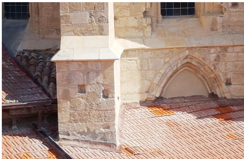
Figura 10: Detalle. Reposición de bota-aguas corrido de piedra natural caliza de Campaspero. Fuente. Fotografía del autor.
