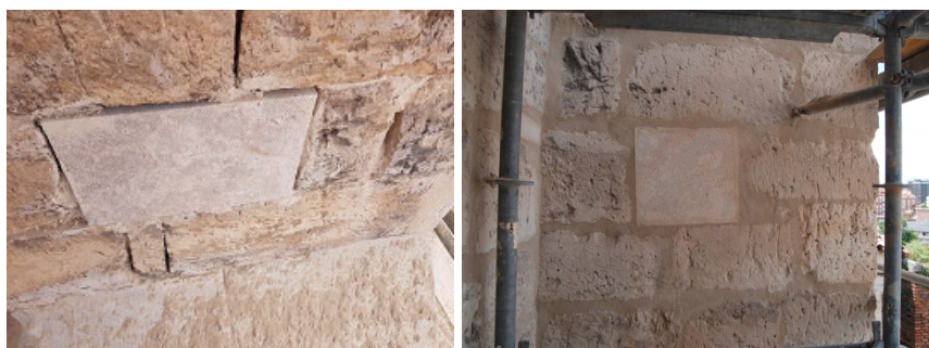
Figura 8: Detalle. Reintegración de piedras nuevas. Fuente. Fotografía del autor.
