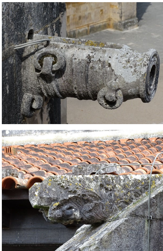
Fig. 18. Cañón. Capillas Imperfectas.
