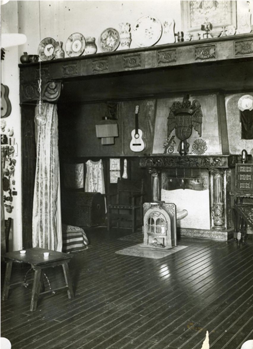
Figura 6: Vista de la chimenea en la salita desde el salón principal. Destaca el hueco adintelado marcado por una viga de madera sobre la que han dispuesto cacharos y cerámicas. (AHPCO. FFRT. F003).
