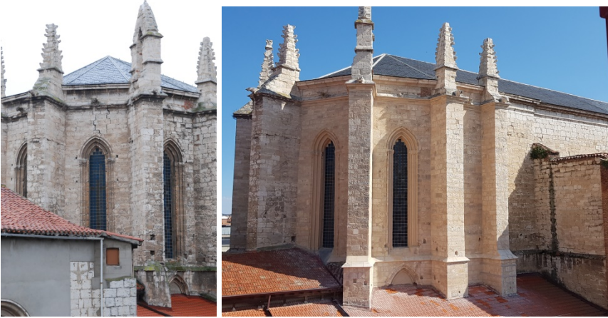
Figura 5: Vista del ábside. Antes (izquierda) y después (derecha) de la intervención. Fuente. Fotografía del autor.
