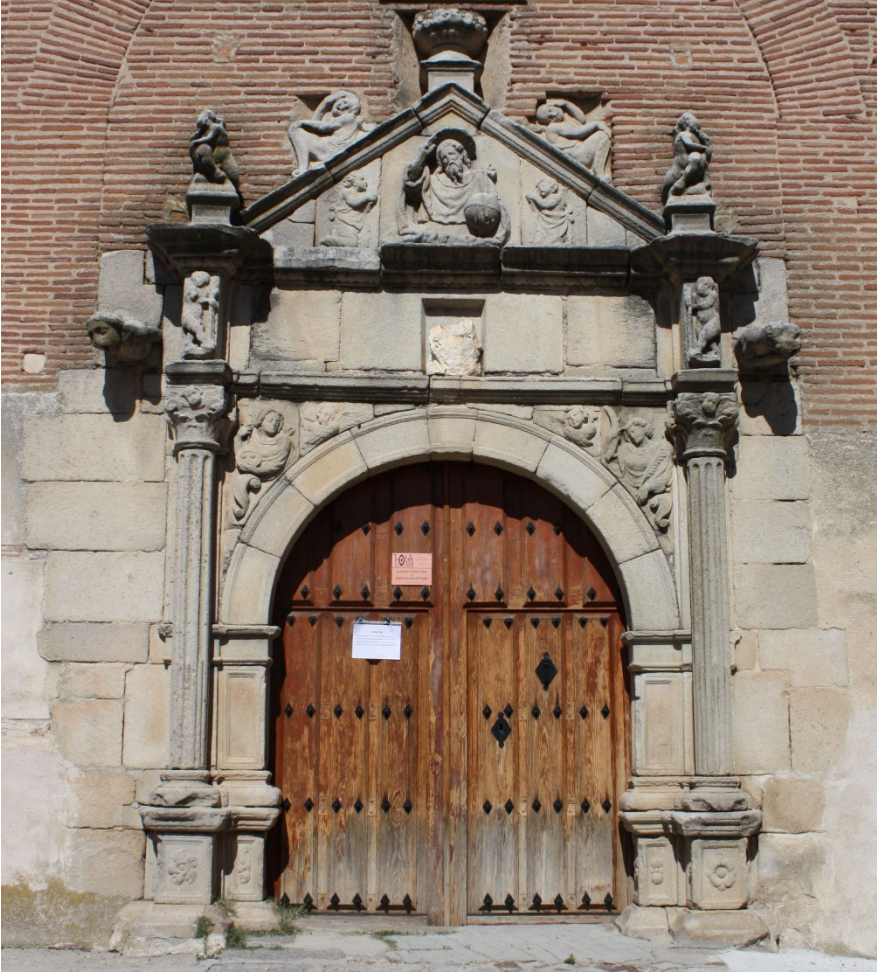
Figura 7: Iglesia de Collado de Contreras Fuente. Los autores
