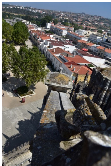
Fig. 3– Solução I, capela do Fundador, arcobotante com calha @Patrícia Alho
