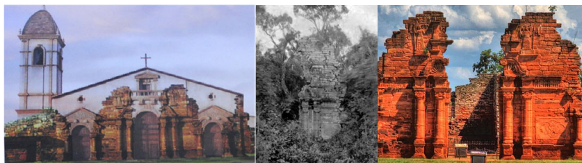
Figura 14 - San Ignacio Miní. Fachada digitalizada, pórtico invadido por la selva y estado actual recuperado. Fuentes: izq - Ma Jesús de la Cerda; centro - Historia de San Ignacio. P. Vicente Gambón; der - Wikimedia.
