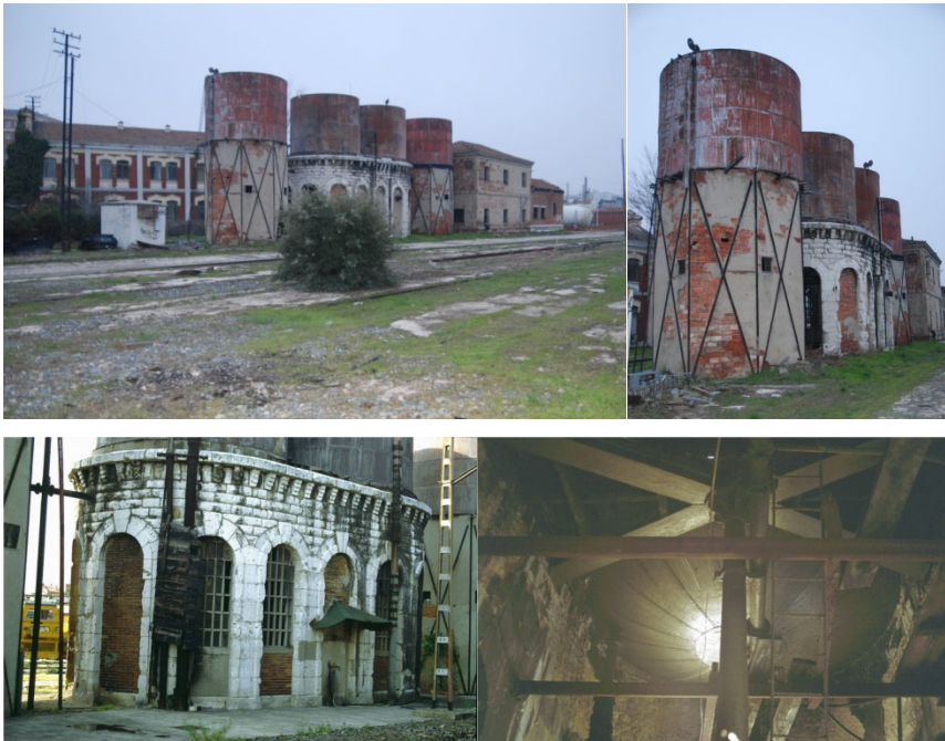
Figura 20: Estado actual de los Depósitos de agua en los Talleres del Ferrocarril de Valladolid.
