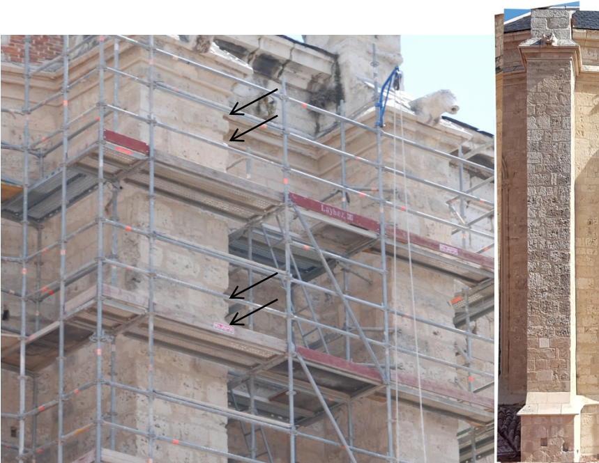
Figura 6: Conformación de la junta entre piedras, mordedura de arista (zona señalada por la flecha) Fotografías de antes y después (derecha) con la arista del contrafuerte completamente recta. Fuente. Fotografía del autor.
