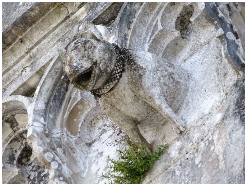
Fig. 2. Perro. Nave norte.
