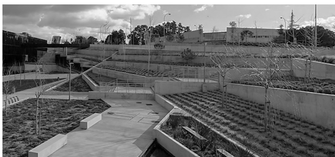
Fig. 36. Imagen de muros de contención Parque Caleido. (Reproducido con permiso de FIA, Fenwick Iribarren Architects).
