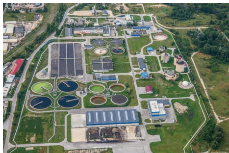
Figura 4. Estación Depuradora de Aguas Residuales (EDAR).
