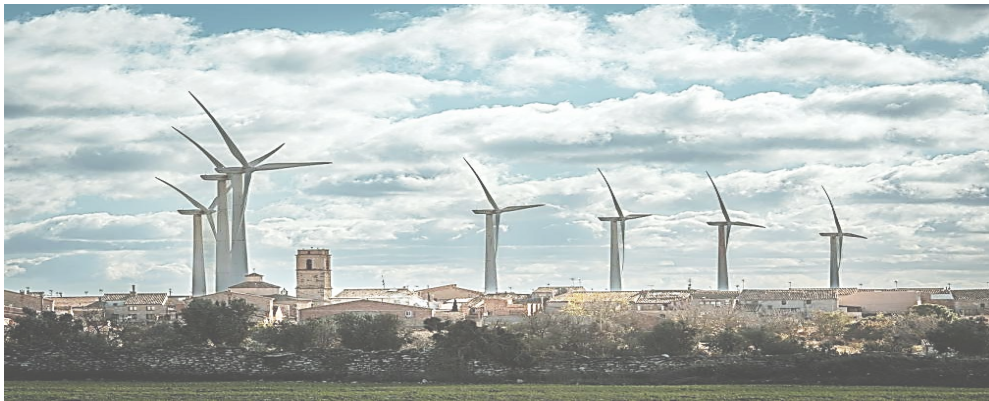
Figura 2: Aerogeneradores de Almatret
