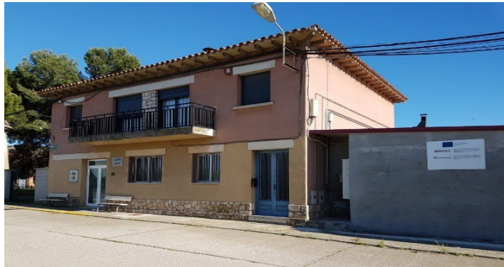
Figura 5: Edificio residencial unifamiliar para la demostración
