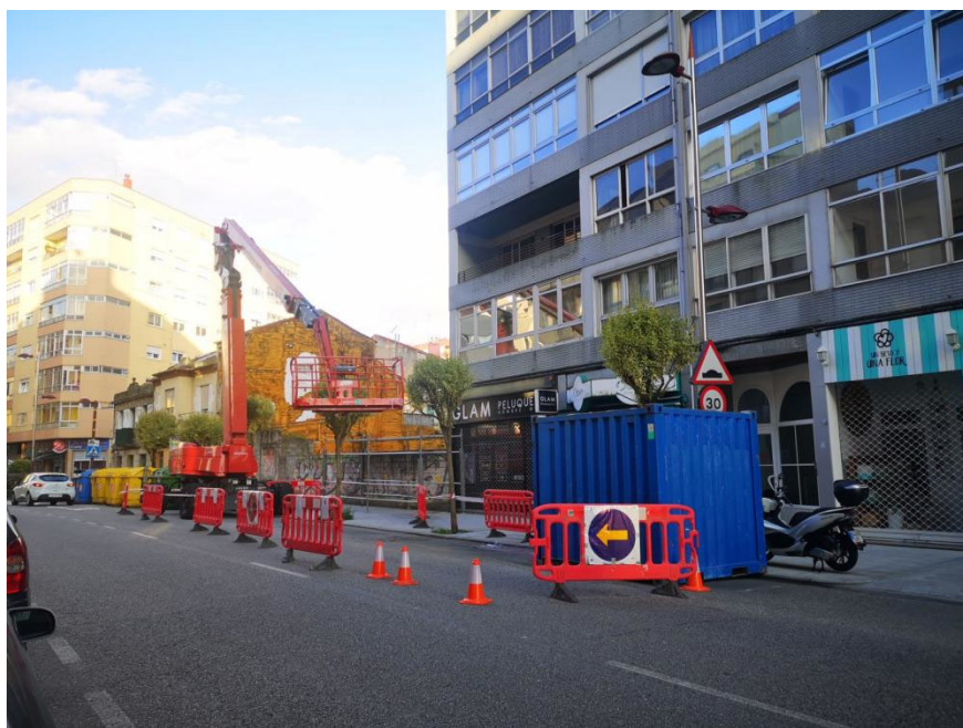
FIGURA 8. Infraestructura y medidas de seguridad necesarias para la creación de un mural en la Avenida Balaidos, en el festival Vigo Cidade de Cor, edición 2021.
