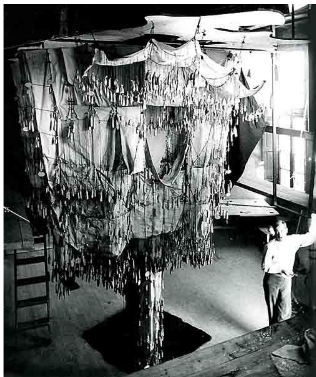
FIGURA 10. Maqueta antifunicular, cripta colonia Güell. Antonio Gaudí, 1898-1914.
