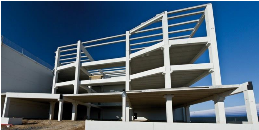
FIGURA 4. Estructura prefabricada de edificación.
