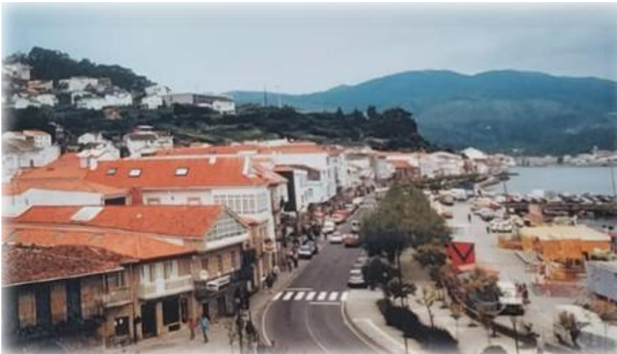
FIGURA 6. Vista de Muros de San Pedro después de la construcción de la carretera principal
