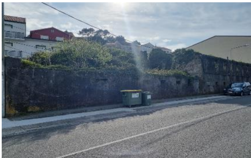
FIGURA 3. Antigua fábrica de conservas de Muros en estado de abandono
