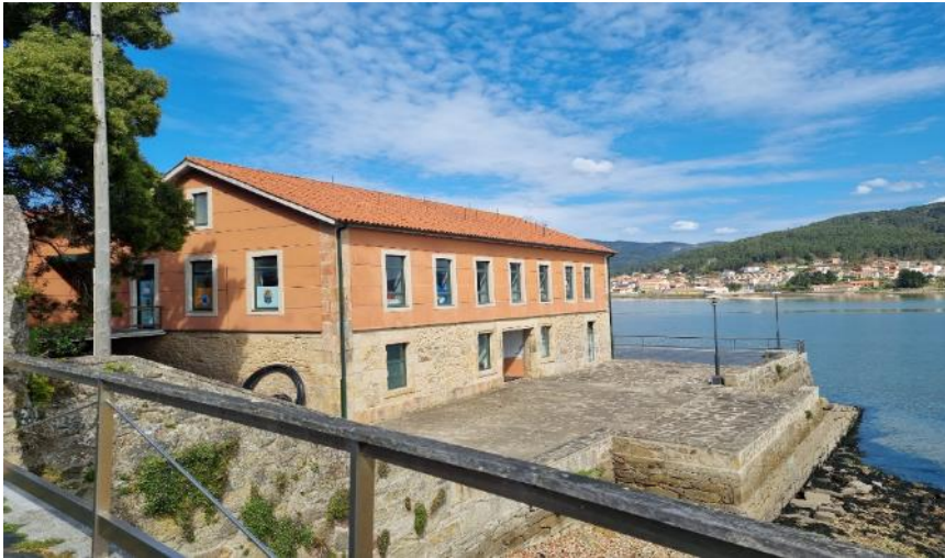
FIGURA 4. Antigua fábrica de conservas de Muros rehabilitada
