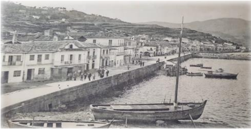
FIGURA 5. Vista de Muros de San Pedro antes de la construcción de la carretera principal
