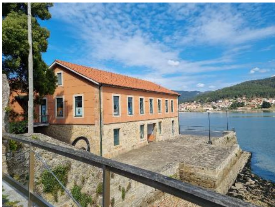
FIGURA 12. Fotografía de la antigua fábrica de Sel rehabilitada en la actualidad
