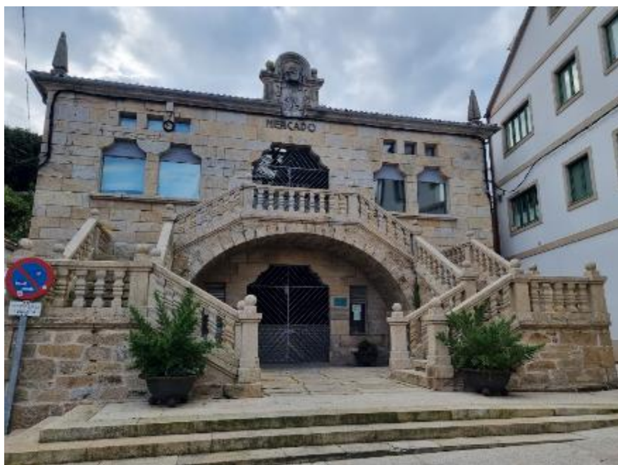
FIGURA 14. Fotografía del mercado situado en la “Praza de Abastos” en la actualidad.
