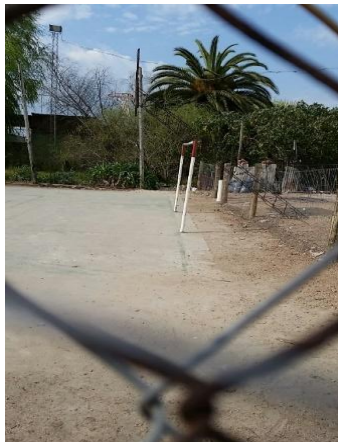
Figura 1. Espacios en mal estado de conservación
