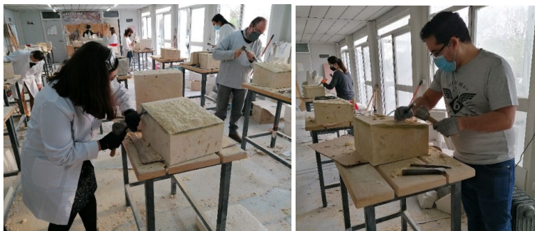
Figura 6. Talla de dovelas en el taller de cantería de la ETSAM (Fuente: MUCRPA)
