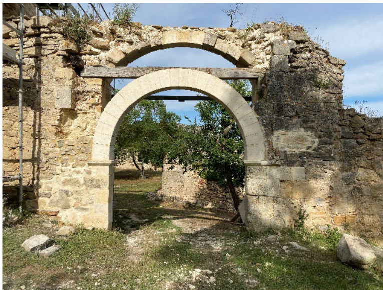
Figura 7. Arco de entrada terminado Fuente: MUCRPA
