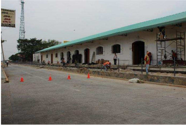
Fuente: Archivo fotográfico propio (Actualización de las vías férreas)
