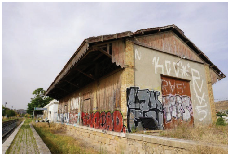
FIGURA 3. Edificio de apoyo (almacenamiento) en Huete.
