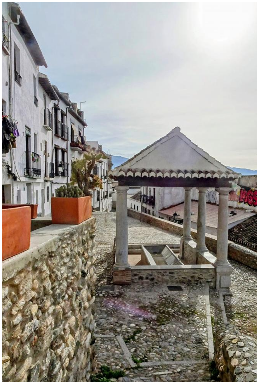
FIGURA 3. Lavadero de la Placeta de la Puerta del Sol de Granada en la actualidad después del proceso de remozado realizado por el Ayuntamiento de Granada (2022-2023).
