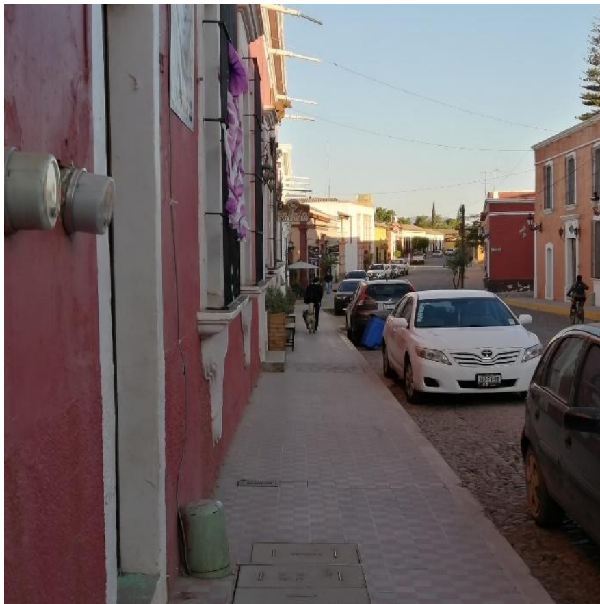
IMAGEN 1. Acera rehabilitada del centro histórico
