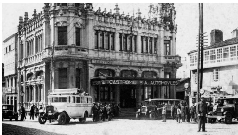
FIGURA 5. Edificio Castromil en los años 30
