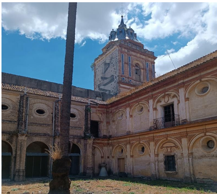
FIGURA 7. Estado actual del Claustro Mayor de San Isidoro. Esquina sureste.
