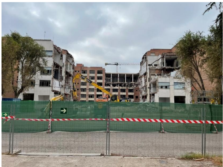
FIGURA 4: Demolición de la fachada y espacios centrales del edificio de Talleres y Oficinas
