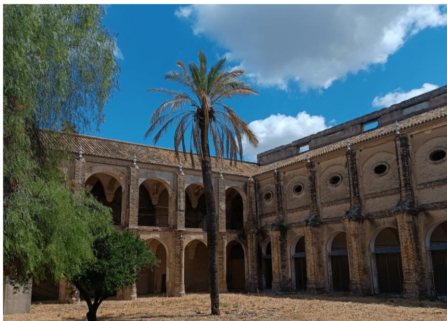
FIGURA 6. Estado actual del Claustro Mayor de San Isidoro. Esquina noreste.
