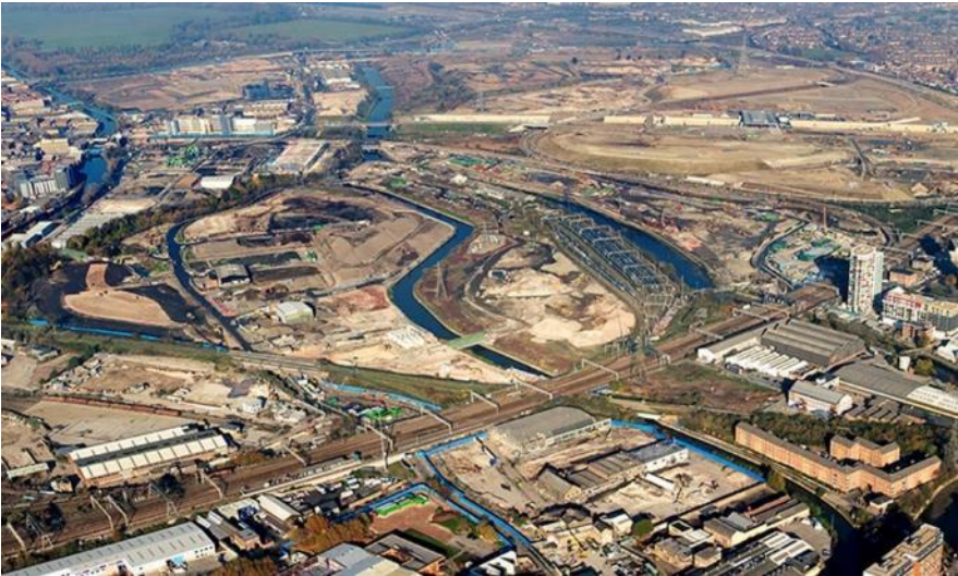
IMAGEN 6. Área antes de las obras para las olimpiadas
