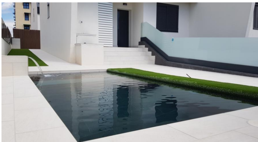
Figura 1: Piscina con acabado interior color negro. Fuente: Piscinas OYC
