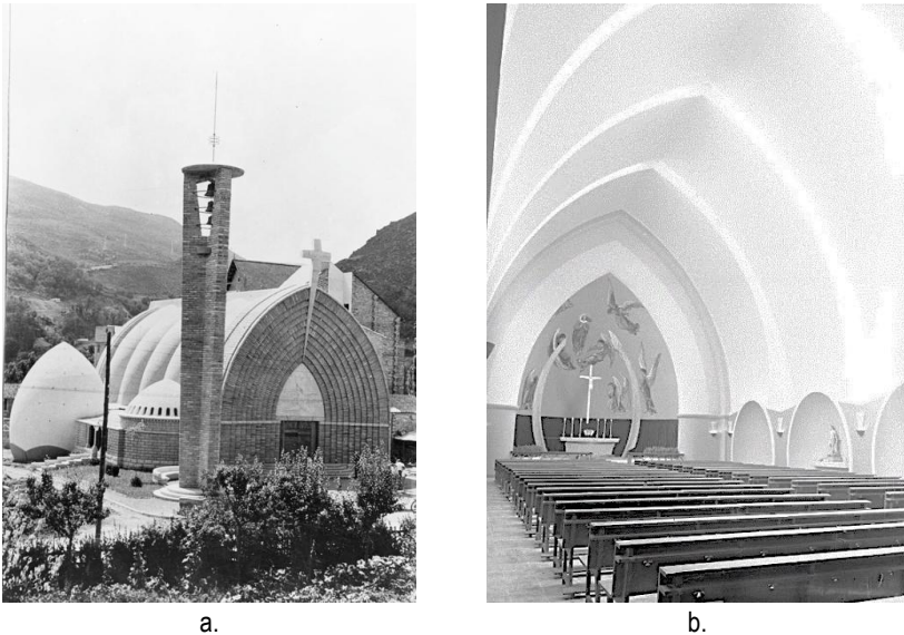
Figure 3: Pont de Suert Church. a. Outside general view; b. Inside general view, towards the altar. (Source: Instituto de Ciencias de la Construcción Eduardo Torroja )
