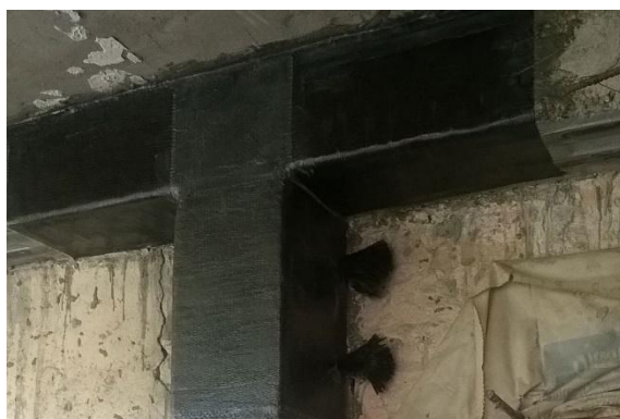
Figura 7 Instalación de refuerzo de CFRP (Carbonveneta, s.f.).
