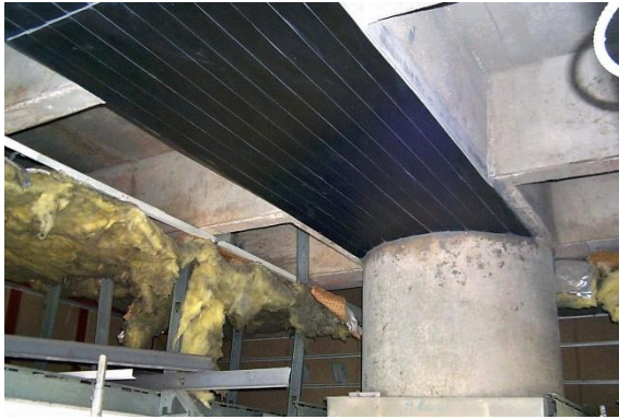
Figura 6 Instalación de refuerzo de CFRP (Carbonveneta, s.f.).
