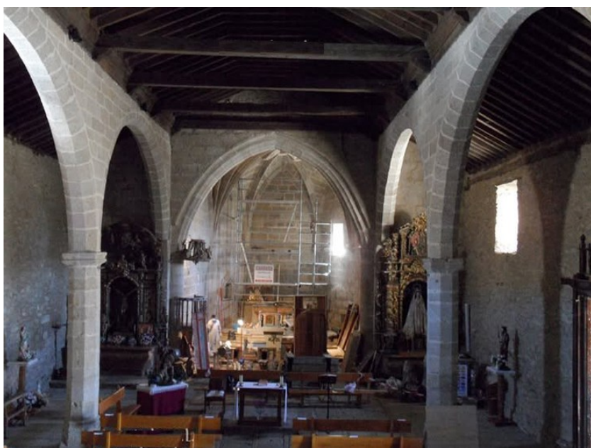
FIGURA 8. Interior de la Iglesia de Santiago de Aravalle (Ávila) con su retablo mayor desmontado y en proceso de restauración
