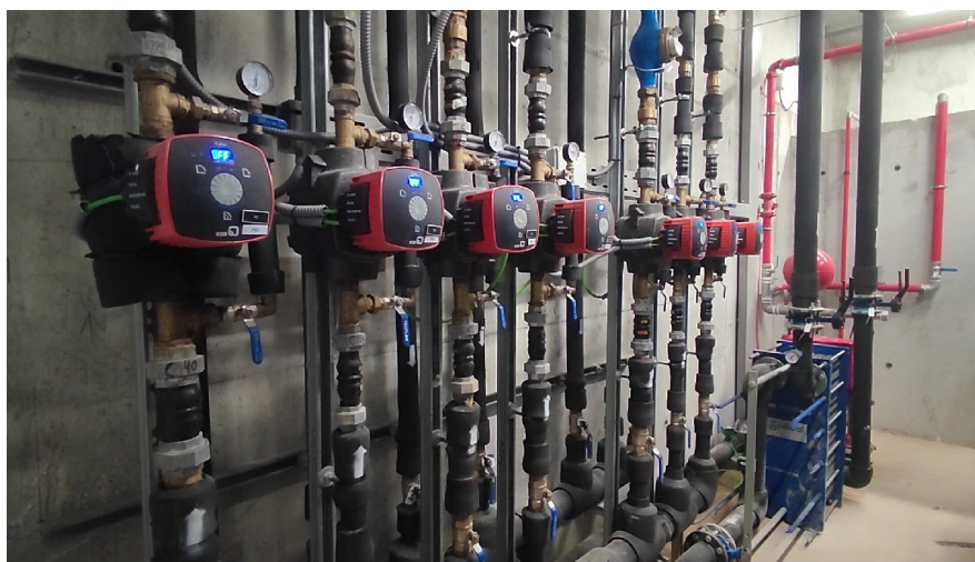
FIGURA 6. Cartuja Qanat, Agora, equipo techo radiante
