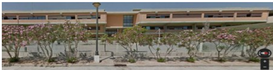
IMAGEN 3. Alzado de la fachada del edificio. Fuente propia
