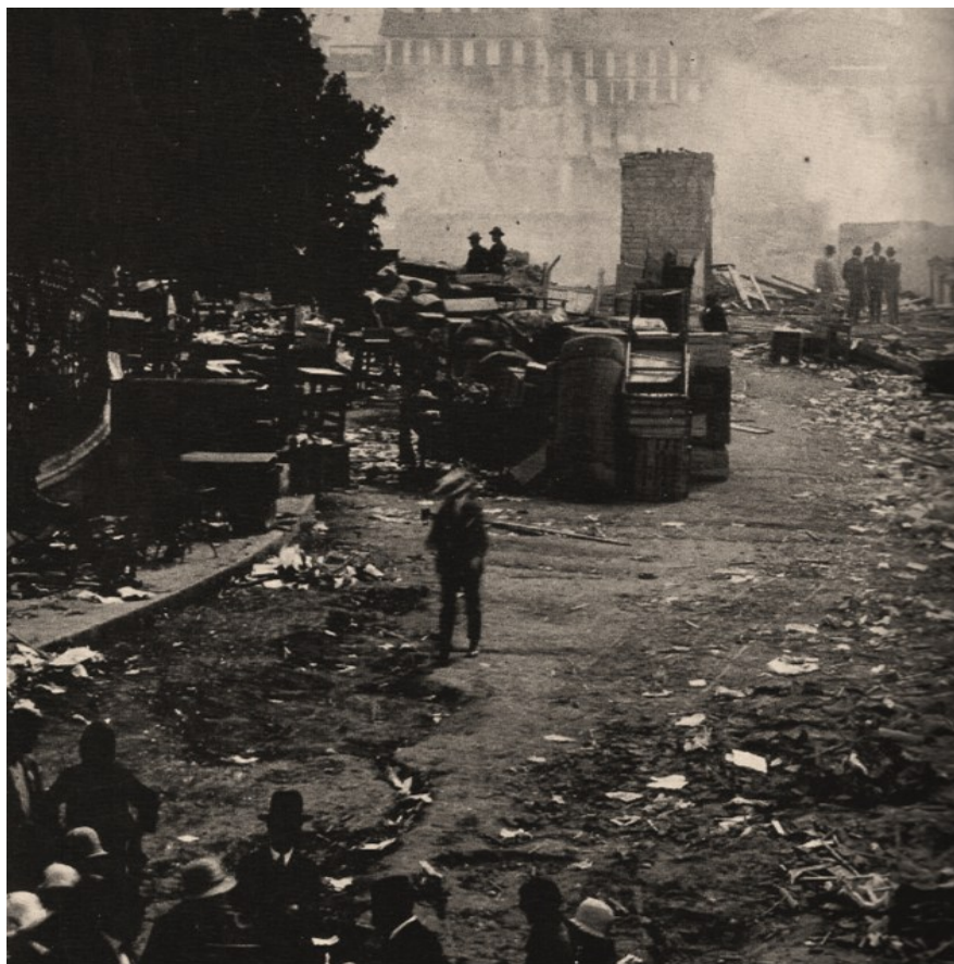
FIGURA 3. Escombros en el parque Bolívar, 1925
