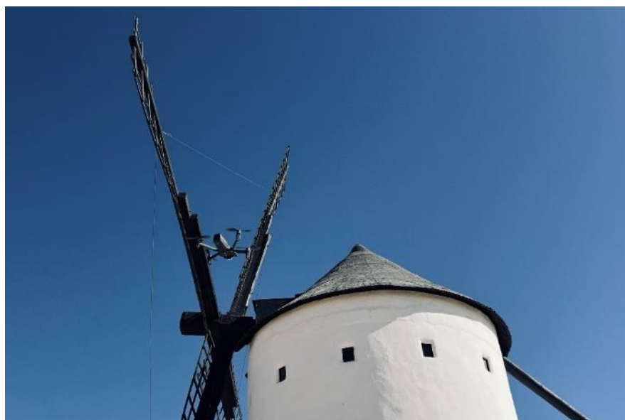
FIGURA 6. Vuelo de un drone junto un molino manchego en Alcázar de San Juan (Ciudad Real) para su reconocimiento e inspección.
