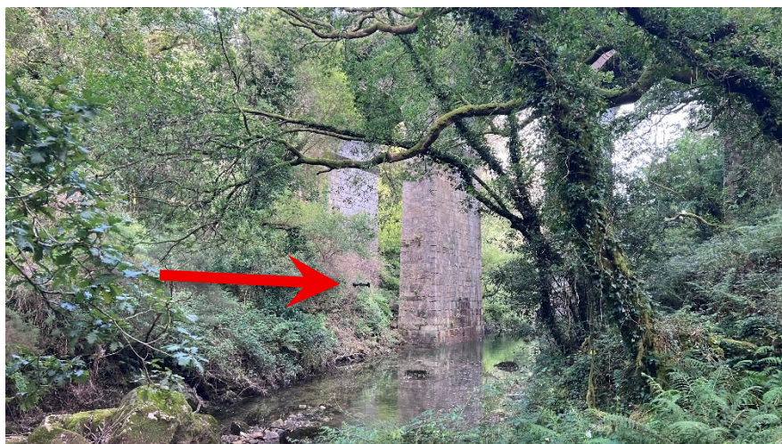
FIGURA 2. Pila del Ponte Peón (Dumbría, A Coruña), acueducto de piedra en un entorno de difícil acceso. Su inspección fue realizada mediante dron debido a la inaccesibilidad del terreno y el entorno
