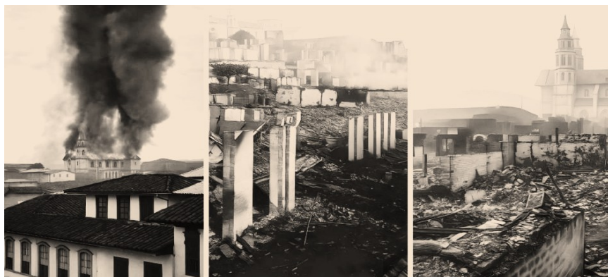
FIGURA 5. Escombros en el parque Bolívar, 1925
