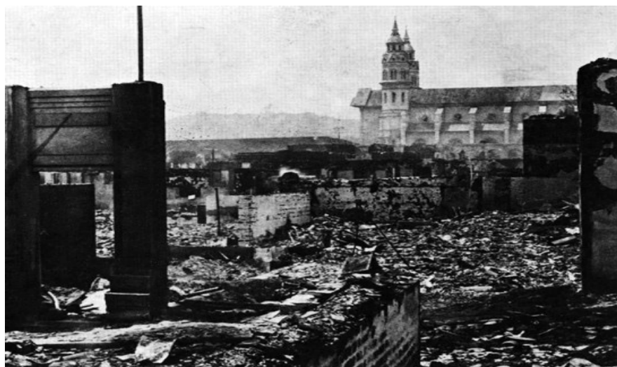
FIGURA 4. Escombros en el parque Bolívar, 1925
