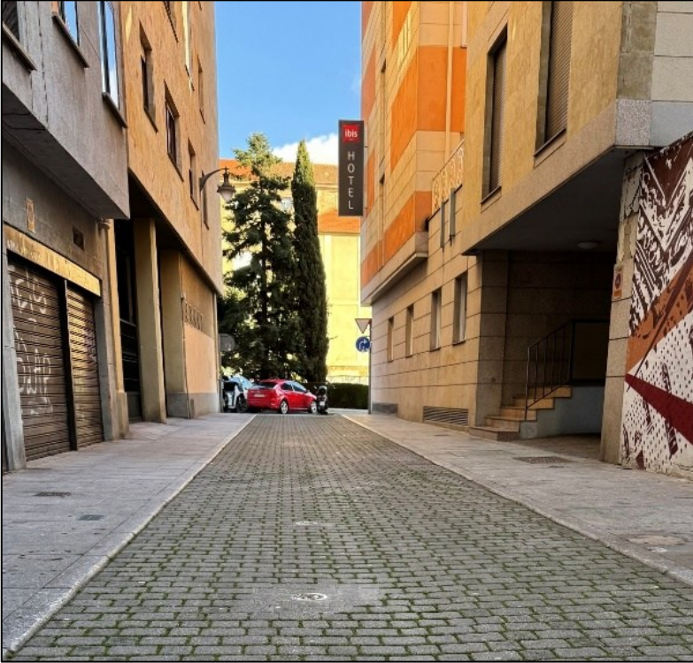
FIGURA 12. Calle en Valladolid con uso de adoquines permeables
