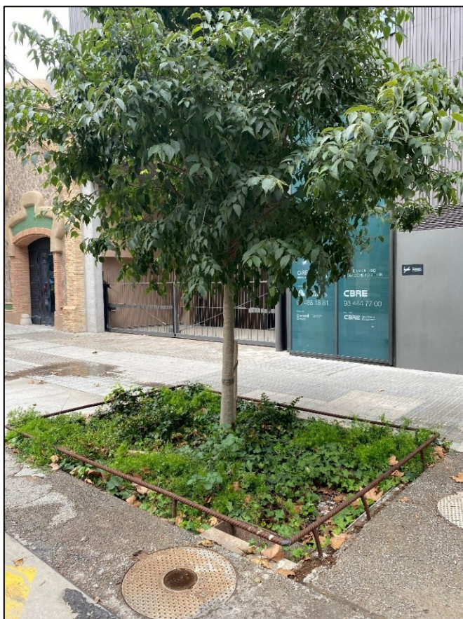
FIGURA 11. Pozos de infiltración en acera de Barcelona
