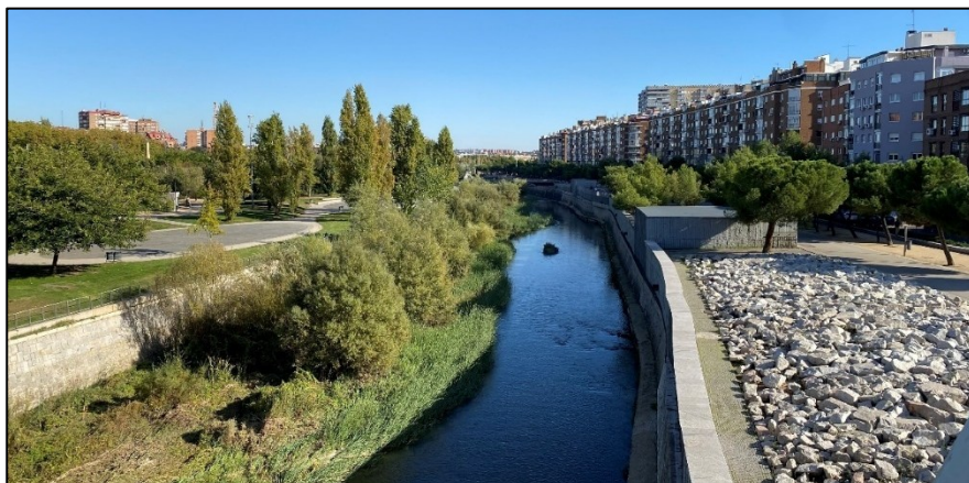
FIGURA 14. Ocupación adecuada de las riberas del río Manzanares, en Madrid
