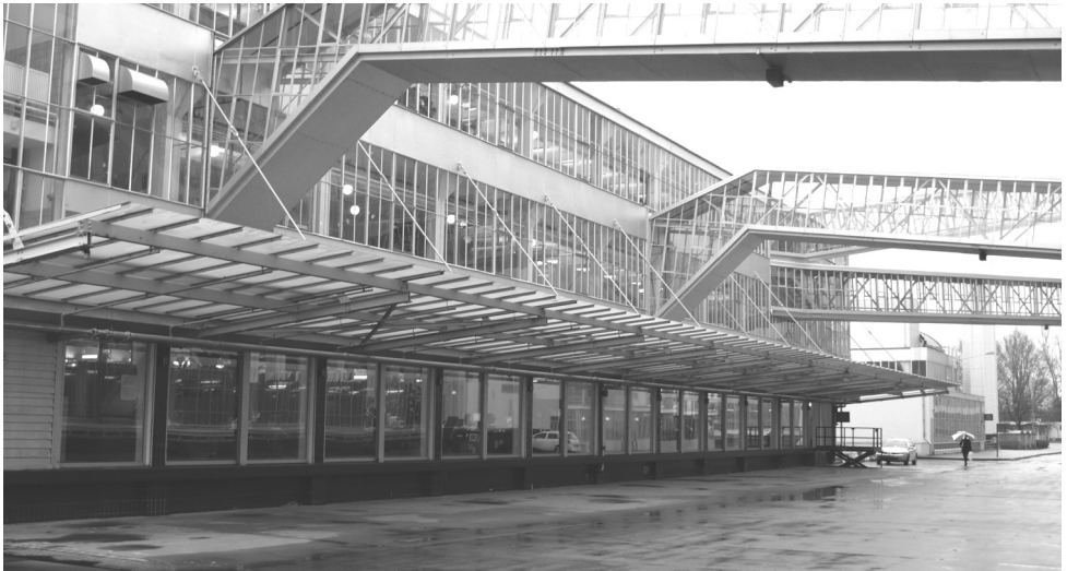
19. Pasarelas y cintas de transporte de la Fábrica Van Nelle. 1926-1931.
